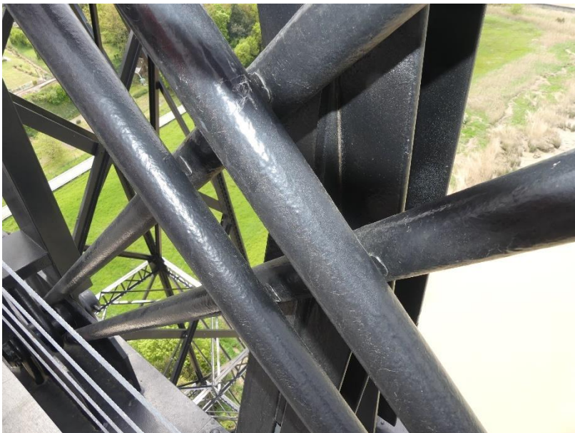
Photo 93 Contact entre les contreventements (diagonales) / Tablier poutre de rive
