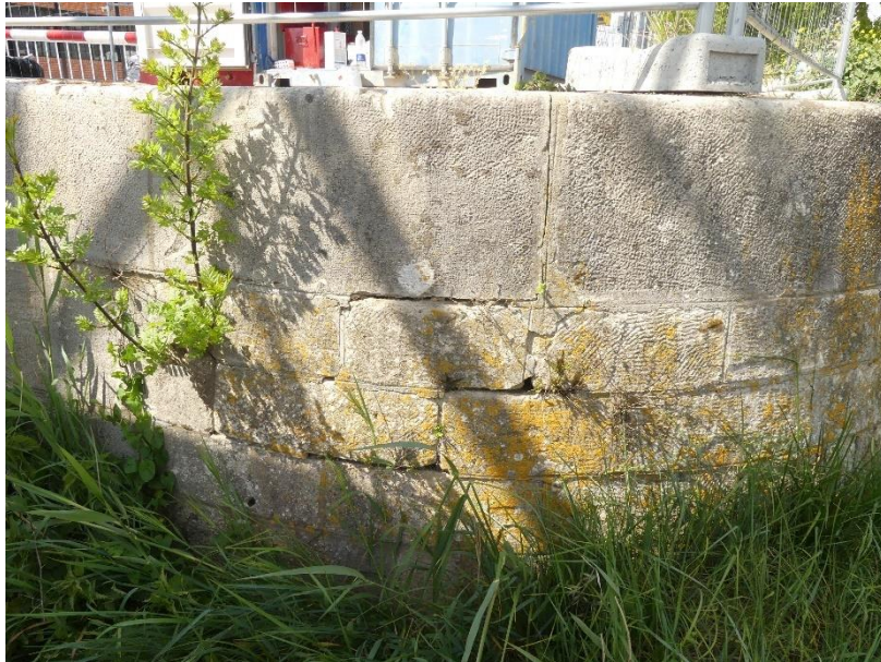
Photo 50 Végétation et fissurations / quai rive droite amont
