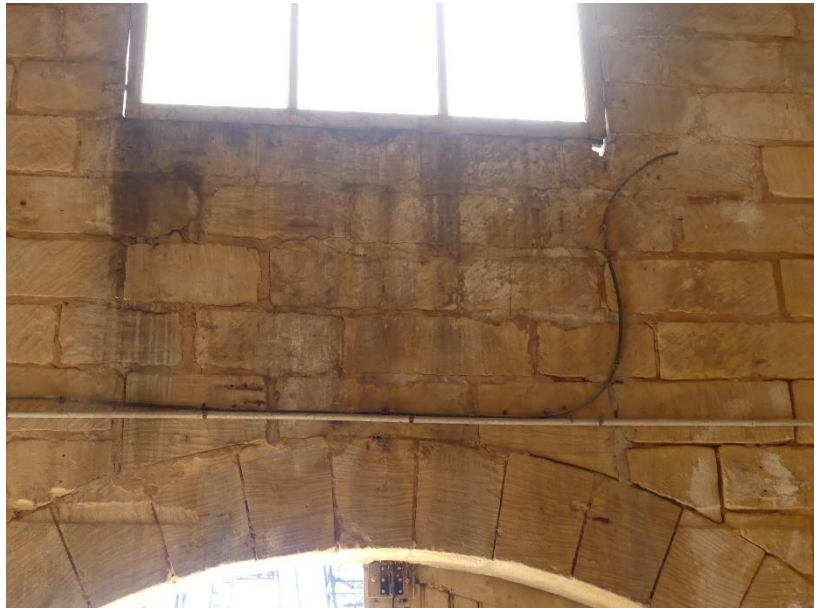
Photo 31 Coulures sous la fenêtre / massif d'ancrage rive droite intérieur
