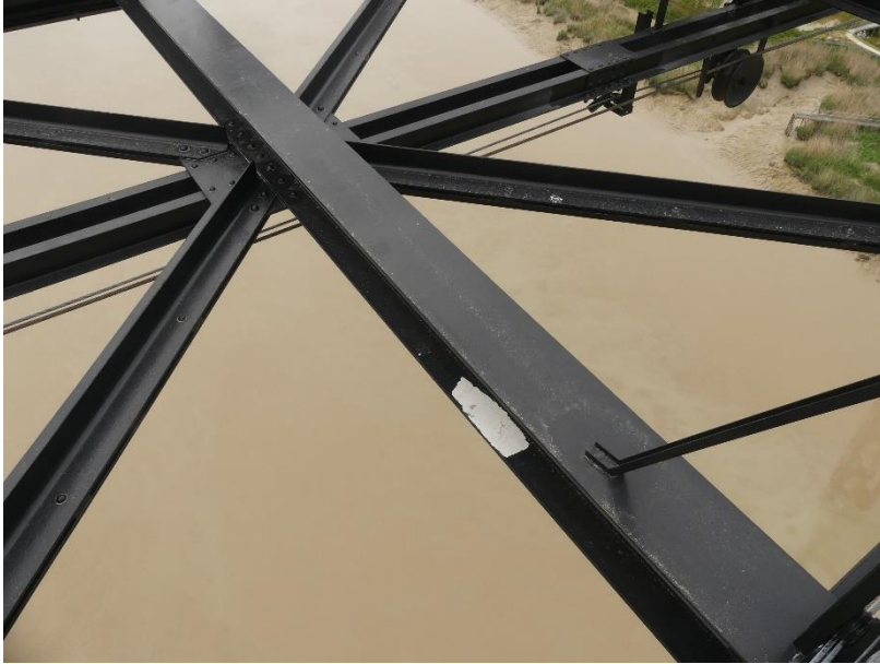
Photo 91 Manque de peinture sur l'entretoise / tablier extrados T12
