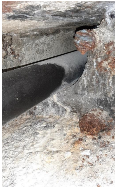
Photo 48 Tirant d'ancrage en contact avec le carottage / chambre de visite rive gauche aval
