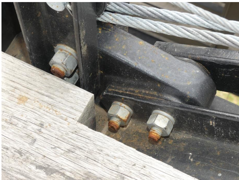
Photo 99 Manque de revêtement et corrosion boulonnerie / Tablier
