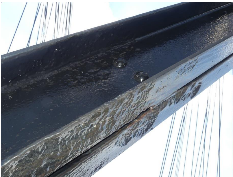
Photo 72 Corrosion entre les profilés / Diagonales de contreventement pylône rive droite
