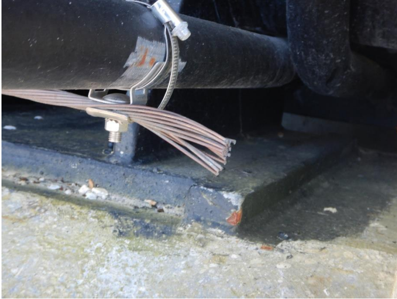
Photo 44 Ecaillage + amorce de corrosion de la platine de scellement de l'axe / ancrage rive gauche amont
