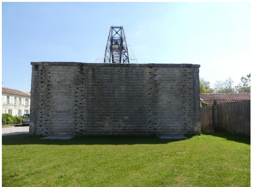
Photo 18 Ancrages des anciens massifs béton non rebouchés / massif d'ancrage rive droite
