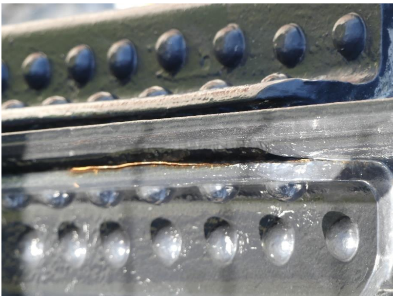
Photo 60 Corrosion entre les équerres de renfort et les m Pylône rive droite aval face intérieure trav
