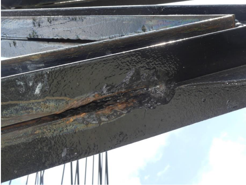
Photo 73 Corrosion entre les profilés / Diagonales de contreventement pylône rive gauche travée 6
