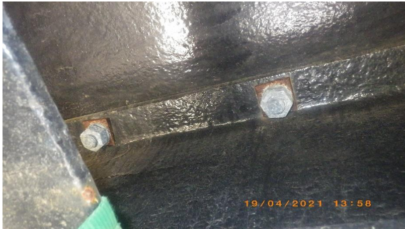
Photo 135 Corrosion des plaquettes / Selles de déviation
