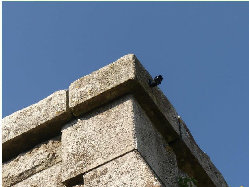
Photo 38 Décrochement de l'angle du couronnement / massif d'ancrage rive gauche
