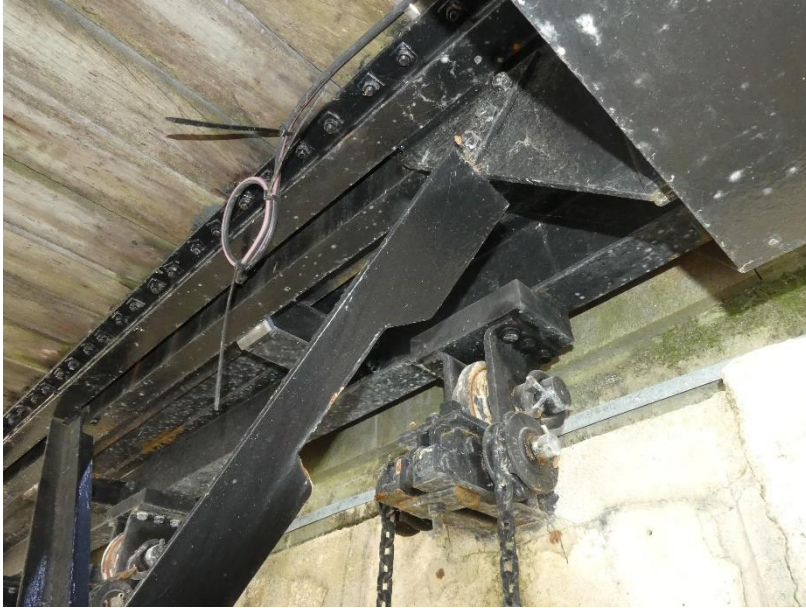
Photo 115 Découpe d'une équerre de déviateur / Nacelle intrados
