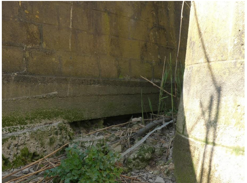
Photo 54 Affouillements sous les murs en retour / quai rive gauche aval
