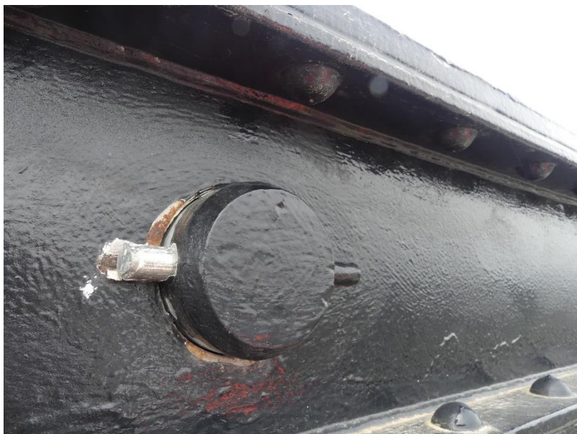
Photo 96 Mouvement de l'axe et de la goupille / Tablier poutre de rive
