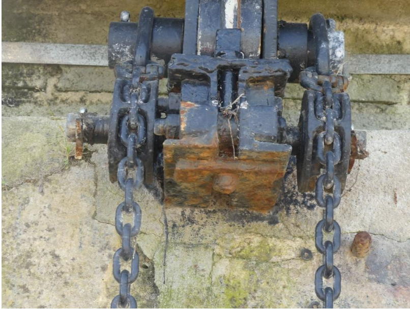
Photo 58 Corrosion sur les éléments métalliques d'accostage / quai rive gauche
