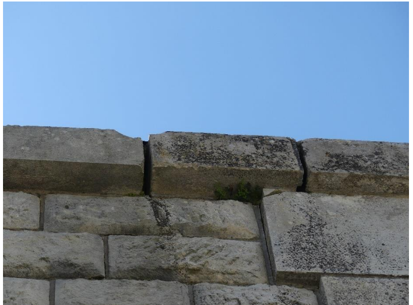
Photo 22 Disjointement + éclat d'une pierre de chaînage / massif d'ancrage rive droite
