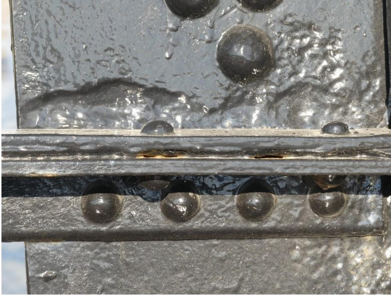
Photo 70 Corrosion entre deux éléments / Pylône rive gauche amont
