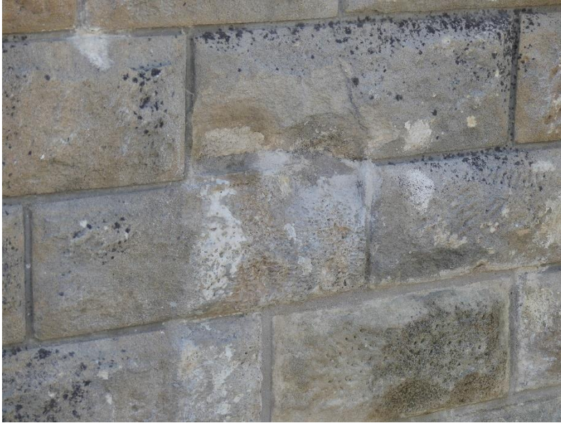
Photo 21 Altération des pierres par zones / massif d'ancrage rive droite
