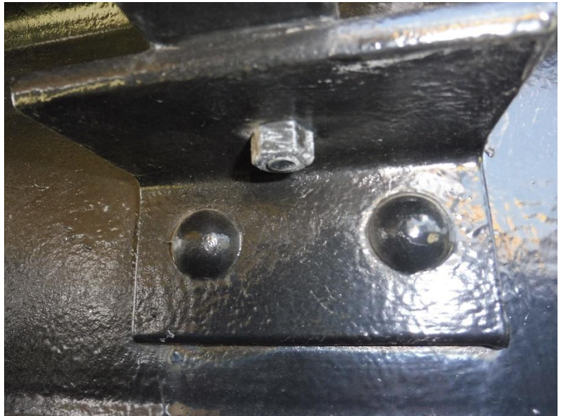
Photo 86 Boulon en fin filetage sur l'équerre de support du platelage / Intrados tablier
