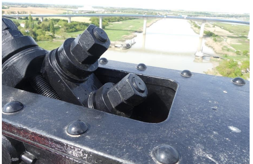
Photo 95 Filetage trop court des contreventements / Tablier poutre de rive TD2 aval
