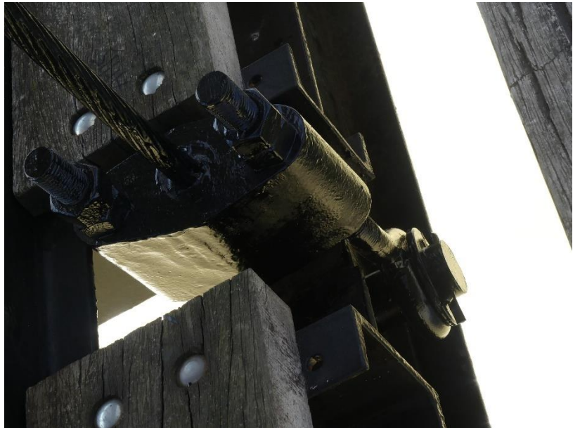
Photo 116 Manque de masticage de culots / Nacelle
