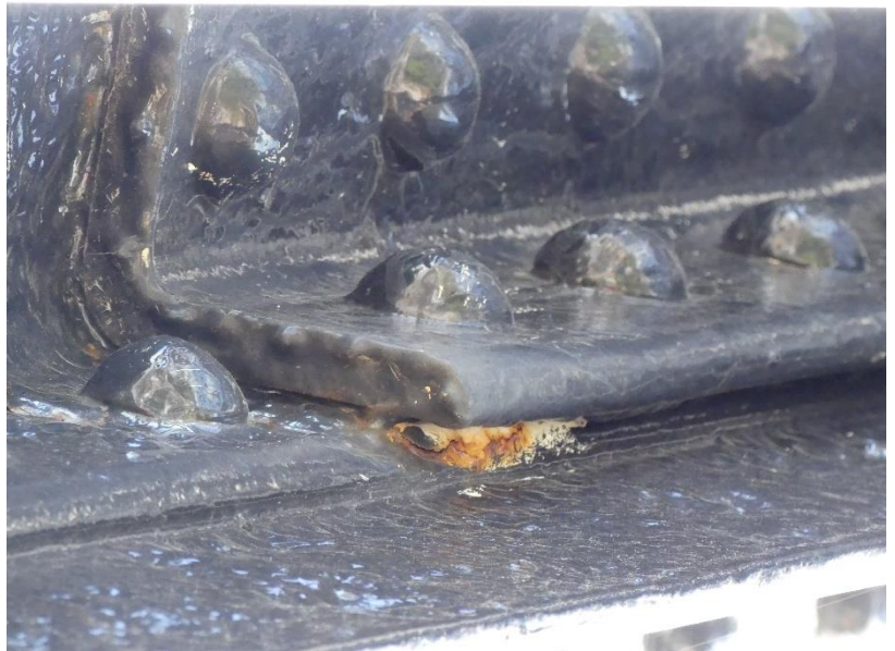
Photo 71 Piqure de corrosion sur une équerre de renfort / Pylône rive gauche amont face extérieure travée 4
