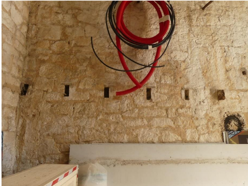
Photo 33 Ancrages des anciennes poutres non rebouchés / massif d'ancrage rive droite intérieur
