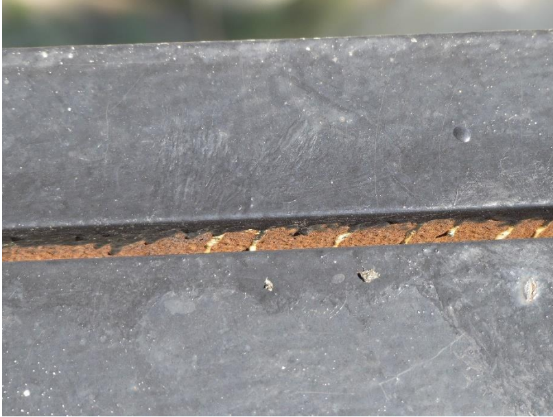
Photo 67 Corrosion en entrefers non-peints / Pylône rive droite aval face extérieure travée 4
