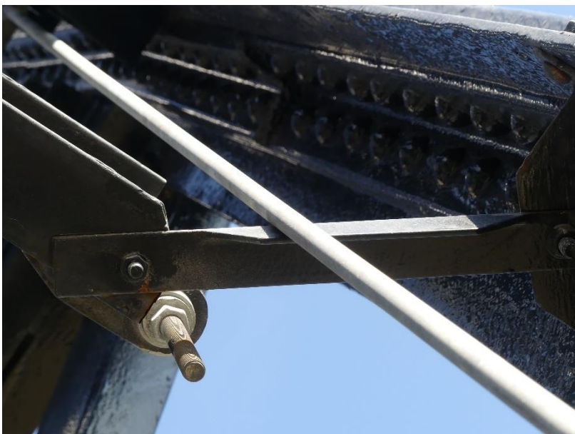
Photo 81 Contact entre suspente et cornière de contreventement / Equipements pylône rive gauche amont travée 5
