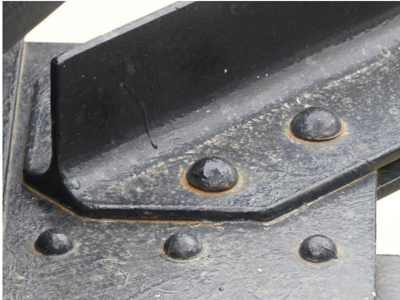
Photo 88 Corrosion entre contreventement et entretoise / tablier extrados TL2RD
