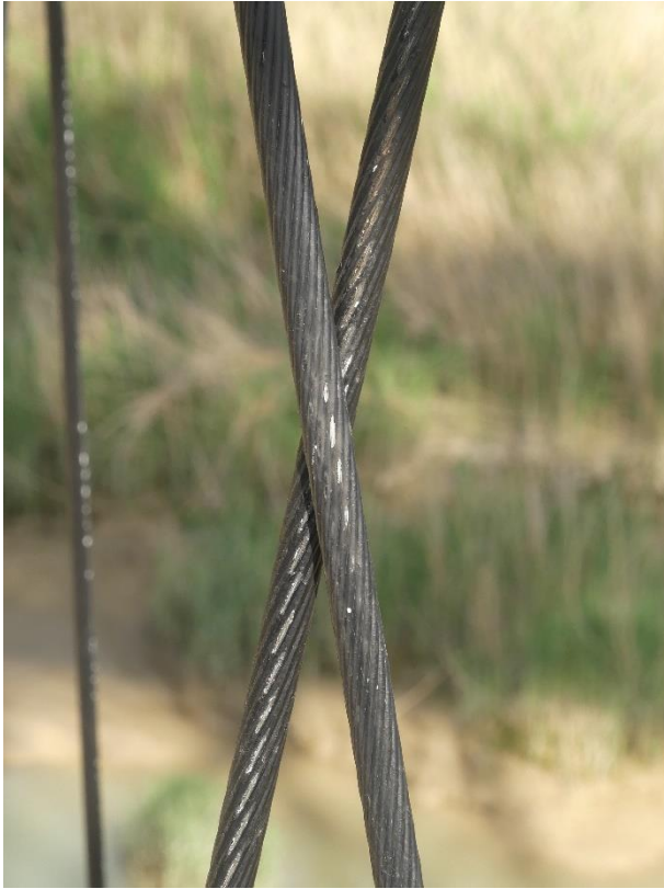
Photo 118 Frottement + corrosion des câbles / Suspendes nacelle
