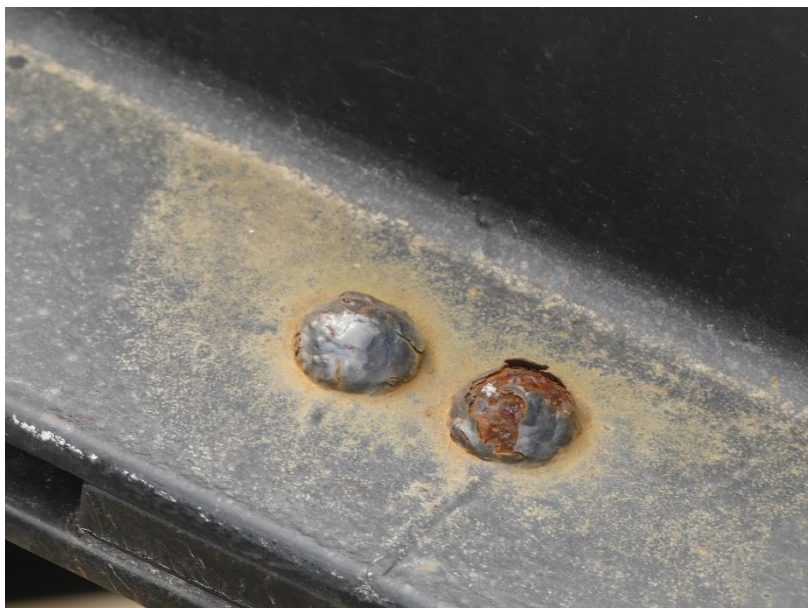
Photo 90 Corrosion et écaillage sur les têtes des rivets / tablier extrados TL2RD
