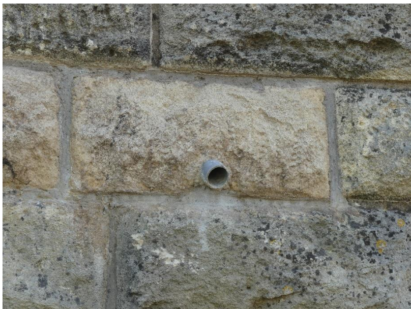
Photo 40 Exutoire de barbacane trop court / massif d'an gauche
