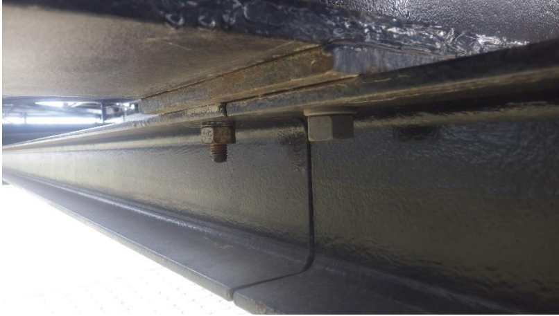
Photo 138 Corrosion sur boulonnerie / Chariot
