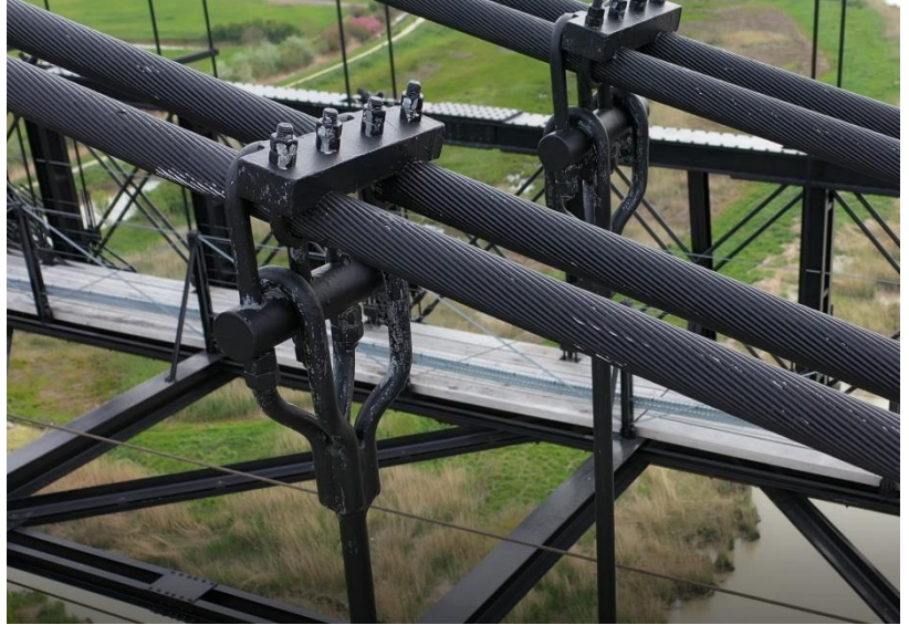
Photo 127 Ecaillage du revêtement / Axe haut des suspentes
