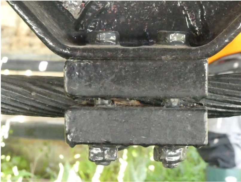
Photo 108 Légère corrosion du câble / Nacelle intrados
