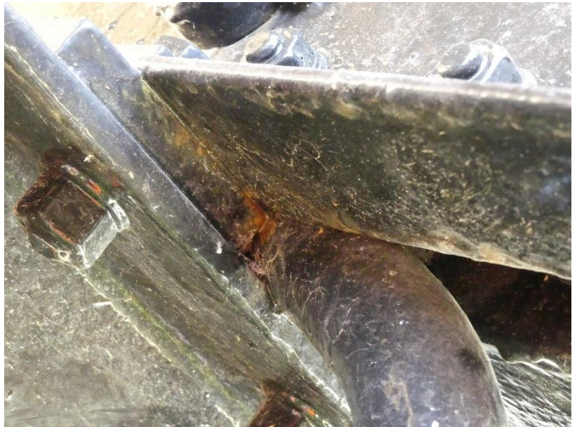
Photo 103 Corrosion de l'étrier au niveau de l'axe / Nacelle intrados
