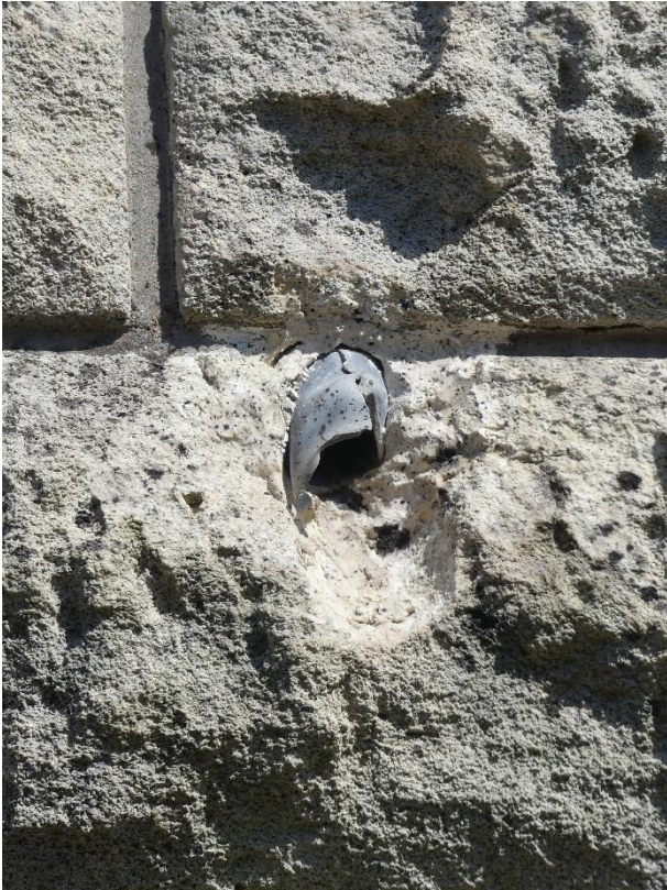
Photo 17 Exutoire de barbacane trop court et endommagé / massif d'ancrage rive droite
