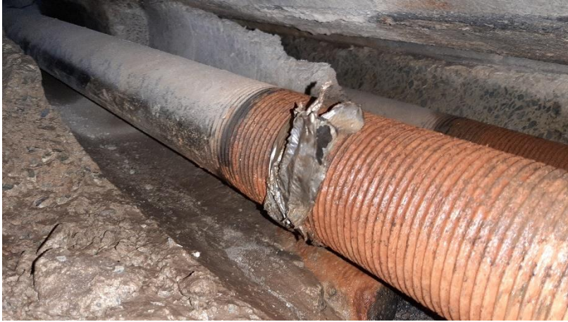
Photo 30 Corrosion des filetages des tirants d'ancrages / chambre de visite rive droite amont
