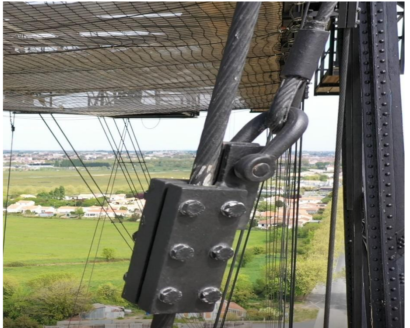
Photo 119 Frottement du revêtement / Suspende nacelle
