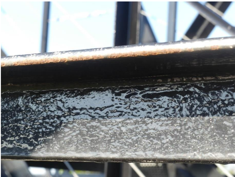
Photo 69 Frottement et corrosion du profilé / Pylône rive gauche amont face Nord travée 2
