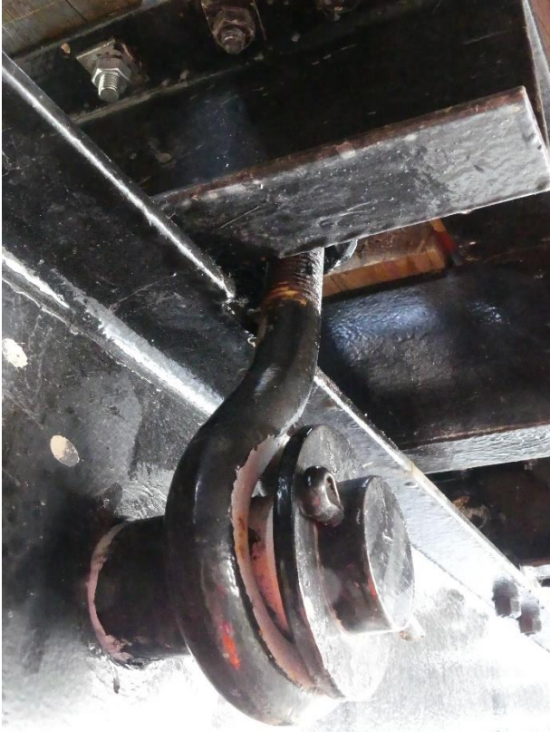
Photo 102 Contact et Corrosion liaison étrier- profilé / Nacelle intrados
