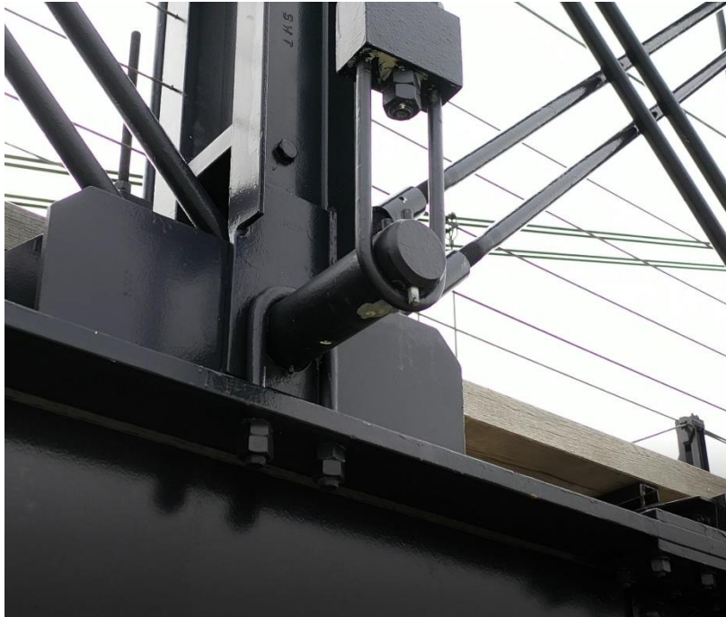
Photo 128 Manque de revêtement et pique et corrosion / Axe bas des suspentes et culot inférieur de suspente
