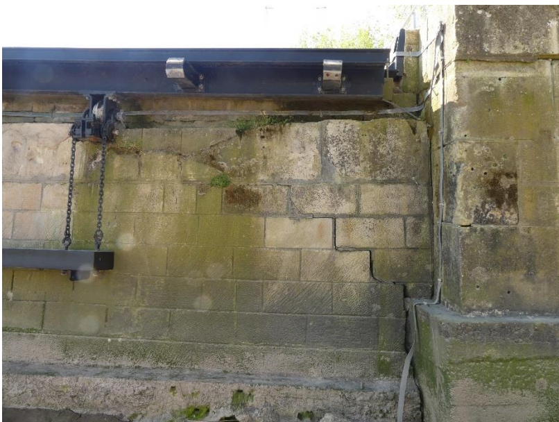
Photo 55 Fissuration importante du quai / quai rive gauche aval
