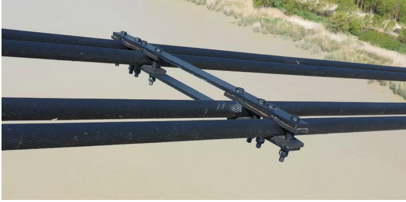
Photo 120 Corrosion / Ecarteur de câbles
