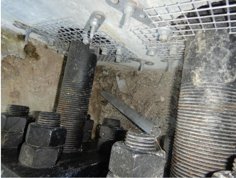
Photo 41 Tube PVC de barbacane coupé trop haut et dépôts / ancrage rive gauche aval
