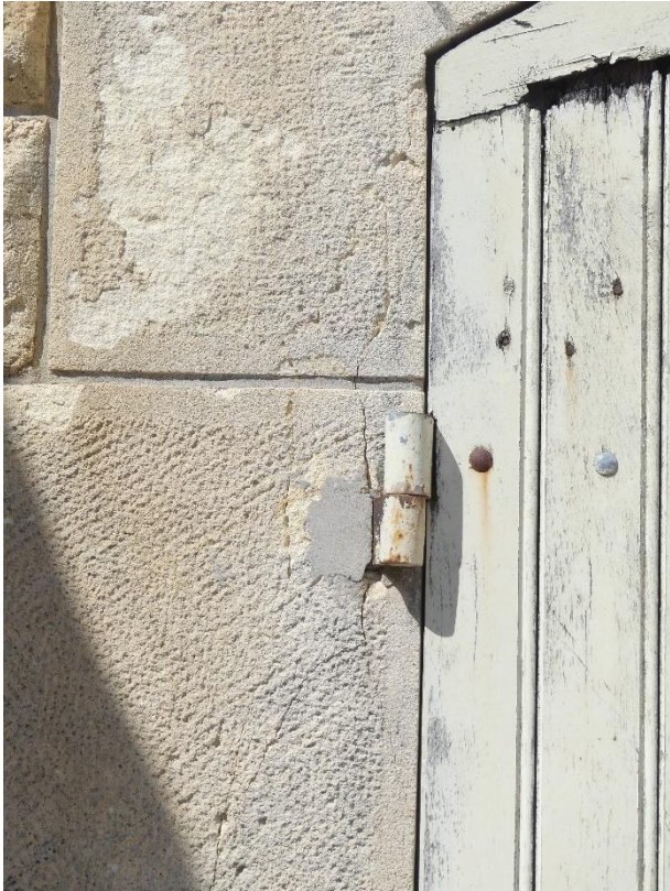
Photo 15 Amorce d'éclats et de fissurations sur les pierres / massif d'ancrage rive droite
