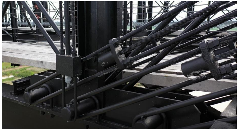
Photo 130 Manque de revêtement sur les suspentes et étriers poutre de rigidité amont côté rive droite
