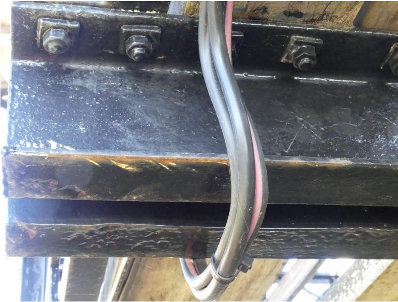
Photo 111 Frottement du profilé et corrosion / Nacelle intrados
