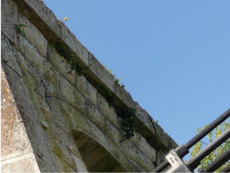
Photo 36 Végétation dans la maçonnerie / massif d'ancrage rive gauche
