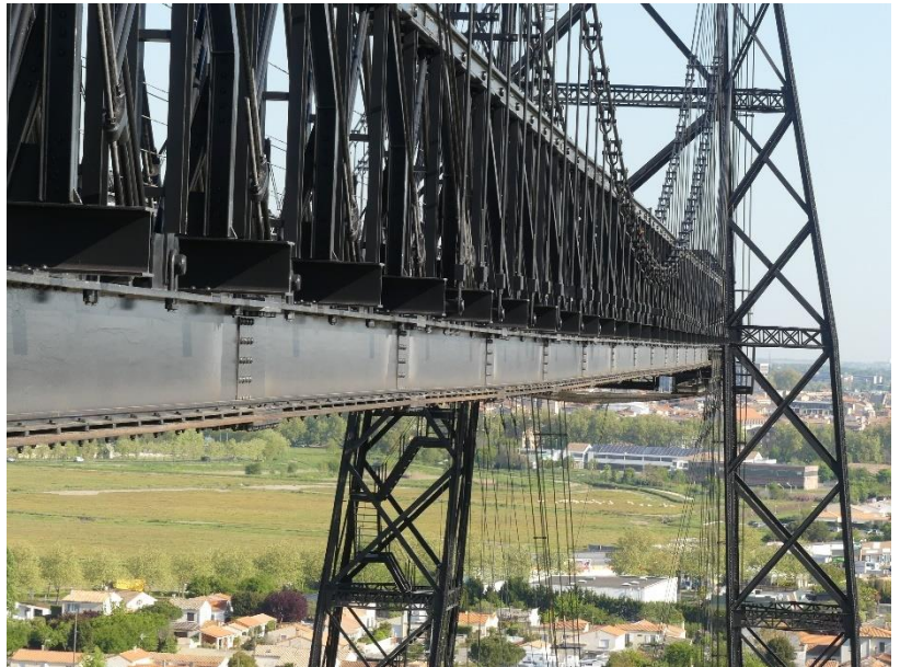
Photo 83 Légère flèche verticale du tablier / Tablier côté amont
