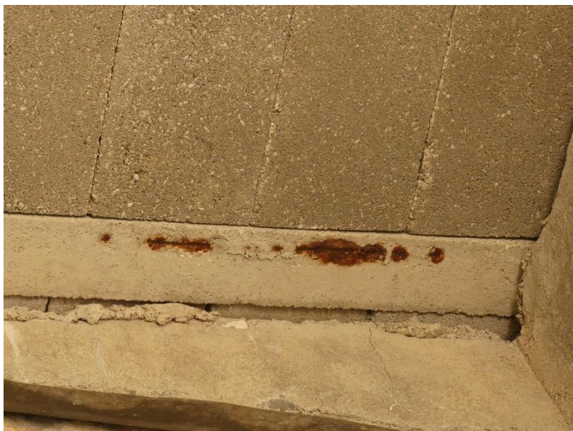
Photo 35 Corrosions sur l'intrados des poutrelles de plafond / massif d'ancrage rive droite intérieur
