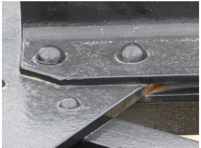
Photo 89 Corrosion entre contreventement et entretoise / tablier extrados TL2RD
