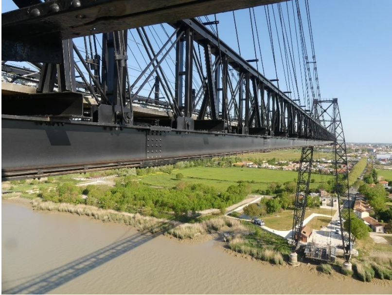
Photo 82 Flèche du tablier à mi travée / Tablier côté amont
