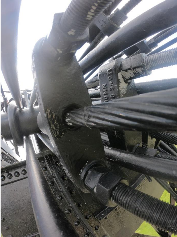
Photo 125 Manque de revêtement anti-corrosion sur les étriers et culots / Câbles porteurs
