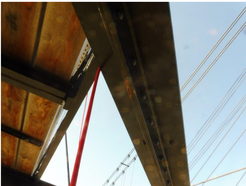
Photo 87 Corrosion du profilé / Intrados tablier
