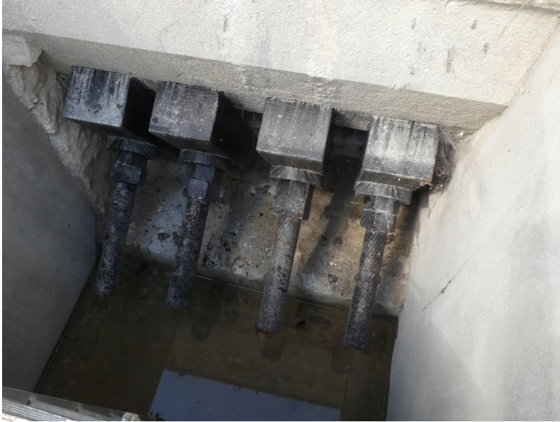
Photo 47 Présence d'eau / chambre de visite rive gauche amont
