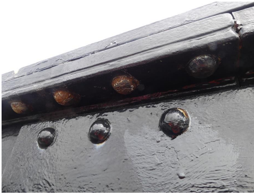
Photo 94 Corrosion au niveau des éclisses / Tablier poutre de rive T1 amont
