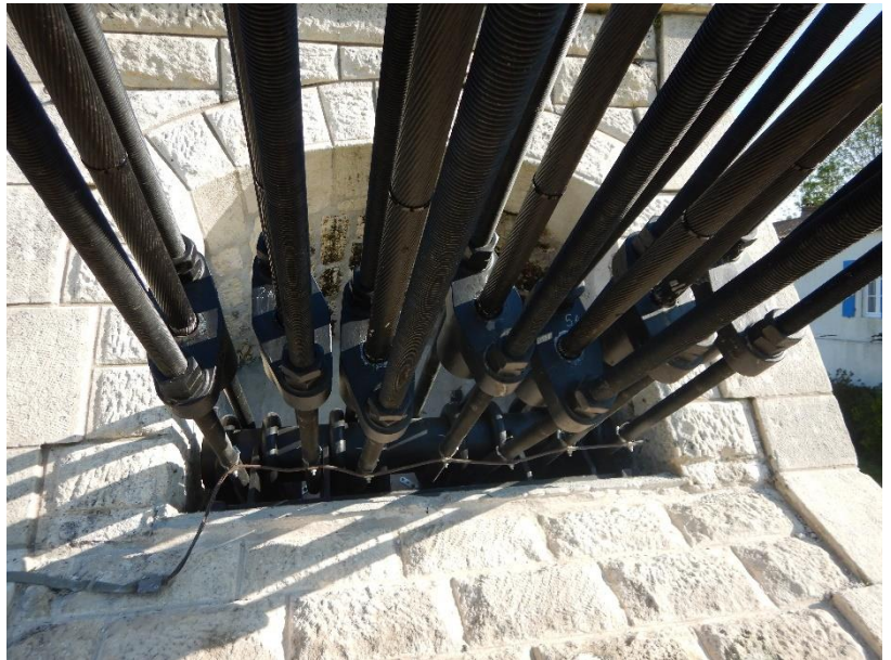
Photo 25 Etrier n°7 non rectiligne / ancrage des câbles rive droite amont
