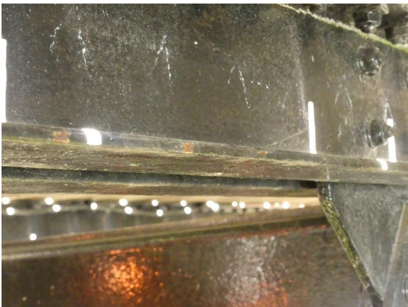
Photo 110 Ecaillage et amorces de corrosion / Nacelle intrados
