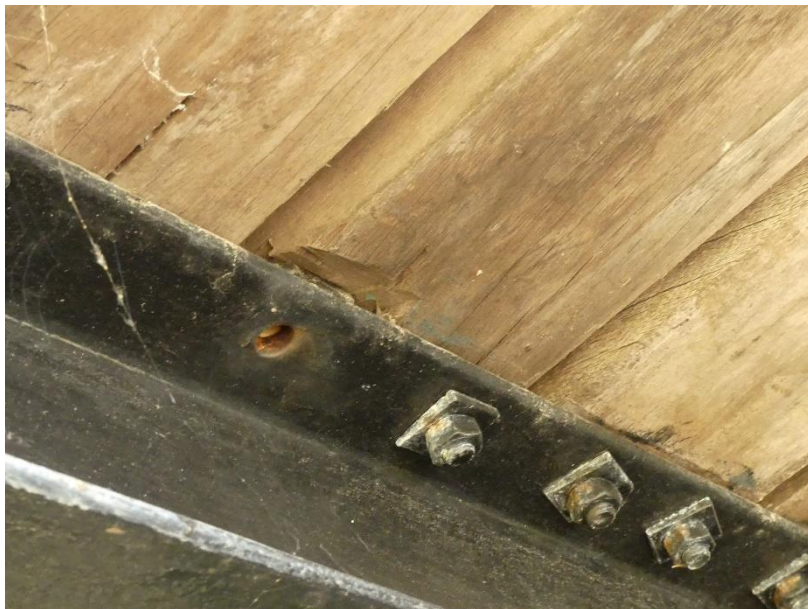
Photo 107 Manque de boulonnerie du platelage et éclat sur lambourde - Boulons serrés en fin de filetage / Nacelle intrados
