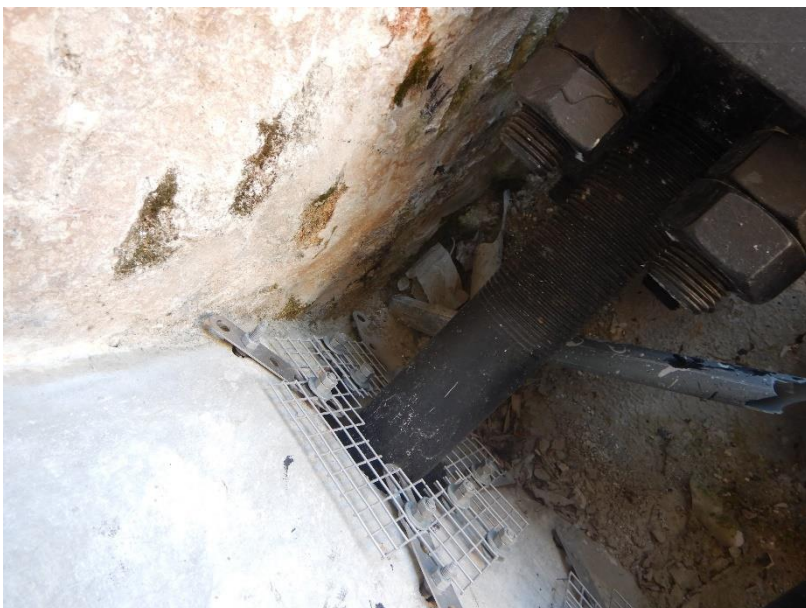
Photo 23 Tube PVC de barbacane coupé trop haut / ancrage des câbles rive droite
