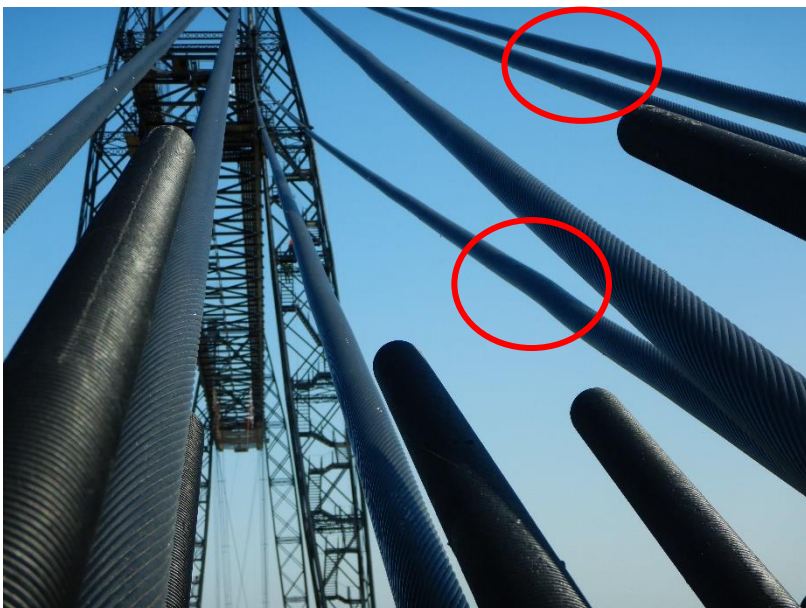
Photo 43 Défaut de rectitude des câbles 3 et 5 à 3m / ancrage rive gauche amont
