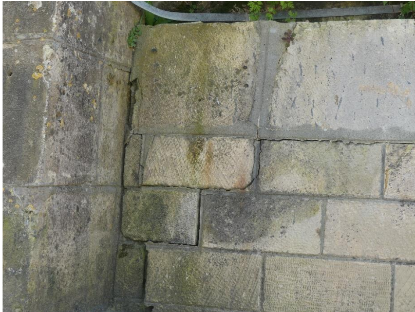
Photo 56 Disjointement important sous le système d'accostage / quai rive gauche amont
