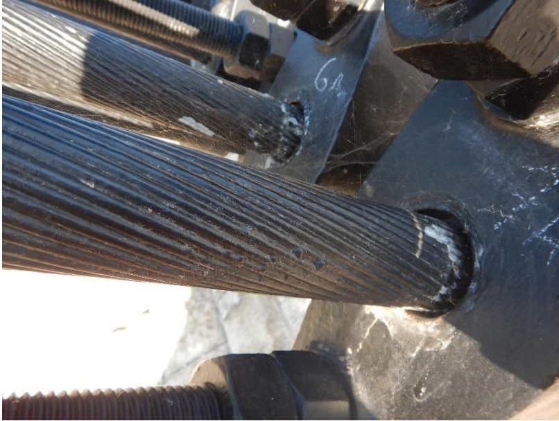
Photo 24 Absence de masticage des culots / ancrage des câbles rive droite amont
