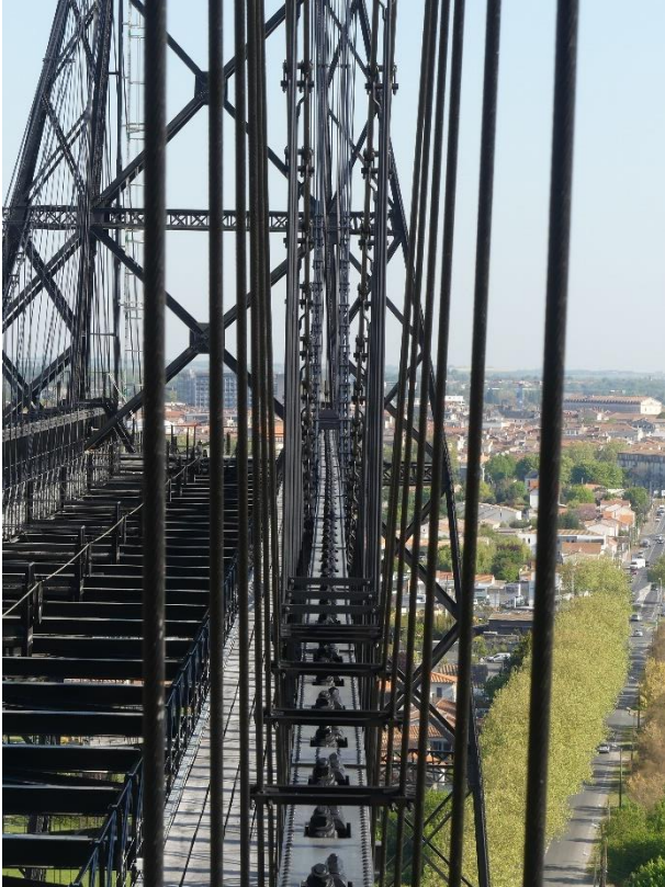
Photo 84 Légère déformation transversale du tablier / Tablier côté amont
