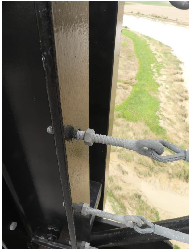
Photo 101 Desserrage d'un câble de GC sur la poutre de rigidité amont sur la travée TRG2 en about du tablier/ Tablier poutre de rive
