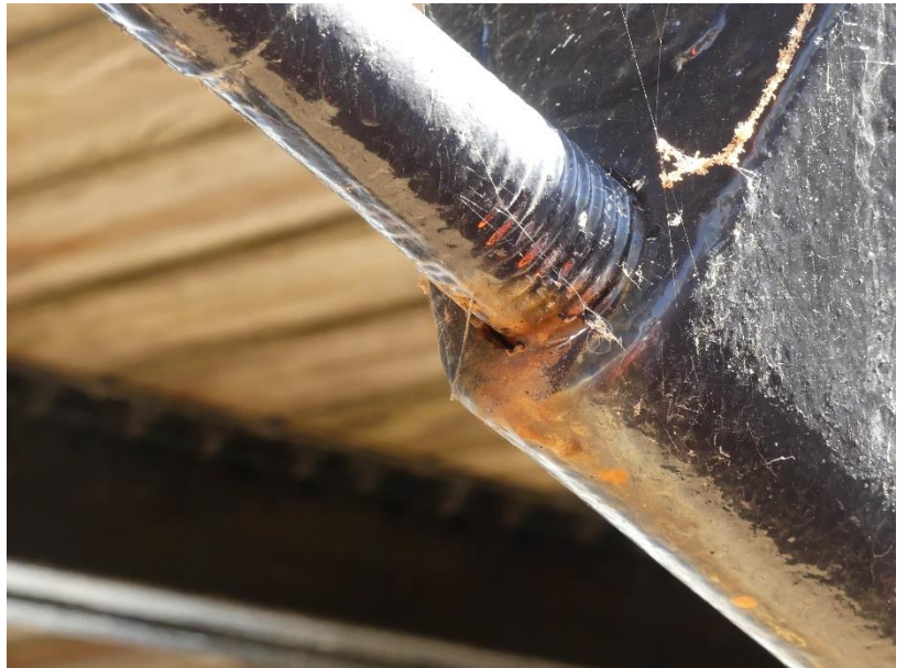
Photo 112 Coulure de rouille sur le culot / Nacelle intrados
