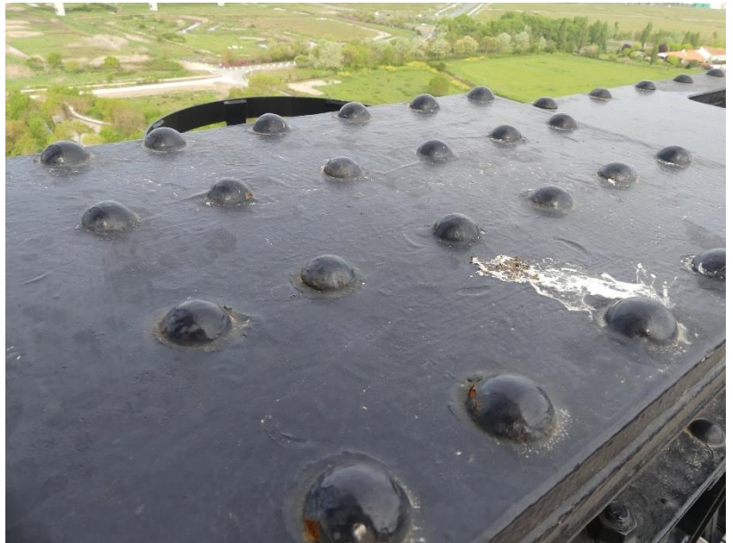
Photo 92 Ecaillage du revêtement et corrosion des têtes de rivet / Poutre de rigidité tablier aval TL1RD
