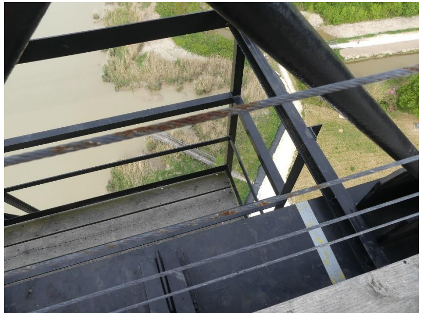
Photo 98 Corrosion câbles de GC au niveau de la poutre de rigidité aval de la TRD1 / Tablier
