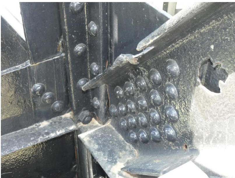
Photo 75 Perte de section / Diagonales de contreventement pylône rive droite travée 6
