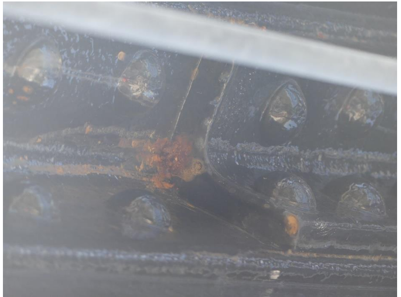
Photo 68 Corrosion sur les équerres de renfort des montants / Pylône rive droite aval face extérieure travée 2
