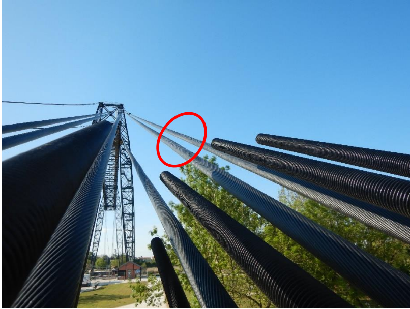
Photo 27 Défaut de rectitude des câbles à 3m des culots / ancrage des câbles rive droite aval
