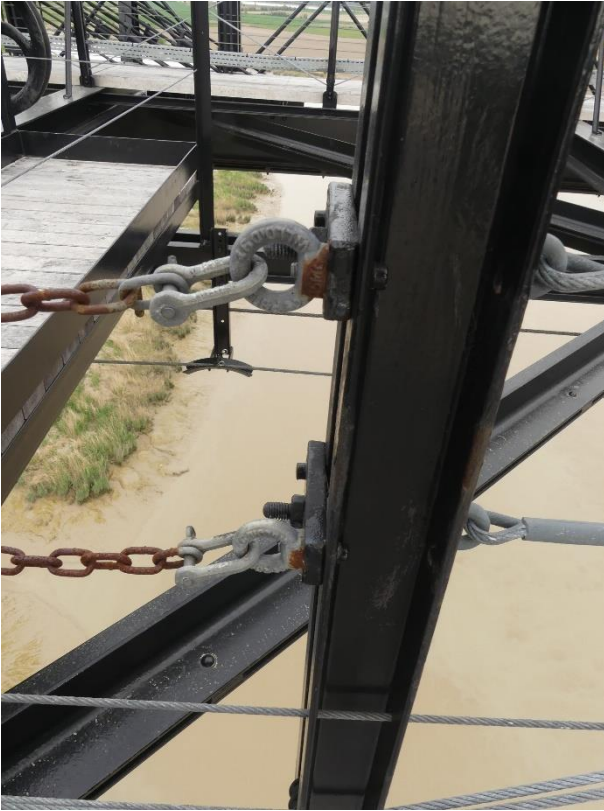
Photo 100 Corrosion des chaînes de GC / Tablier
