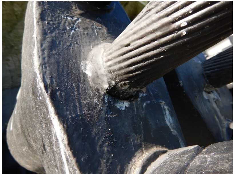
Photo 42 Décollement et craquelage du masticage des culots / ancrage rive gauche aval
