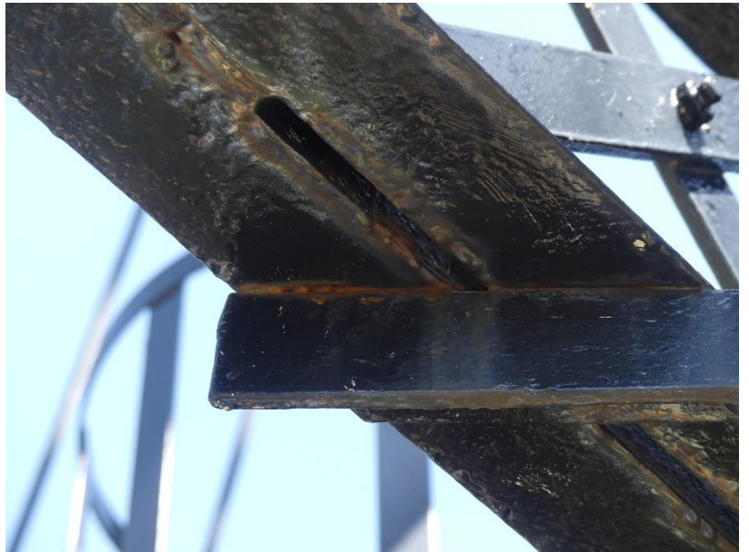
Photo 62 Corrosion entre les contreventements et les traverses inférieures / Pylône rive droite aval face Nord travée 5
