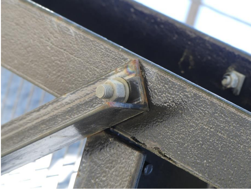
Photo 79 Boulonnerie non peinte / Equipements pylône rive droite aval travée 5
