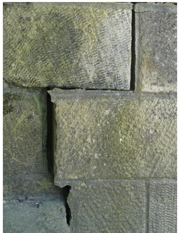
Photo 57 Fissuration importante et désaffleurement sous le système d'accostage / quai rive gauche amont
