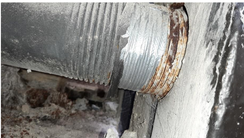
Photo 49 Corrosion sur les filetages des tirants / chambre de visite rive gauche amont
