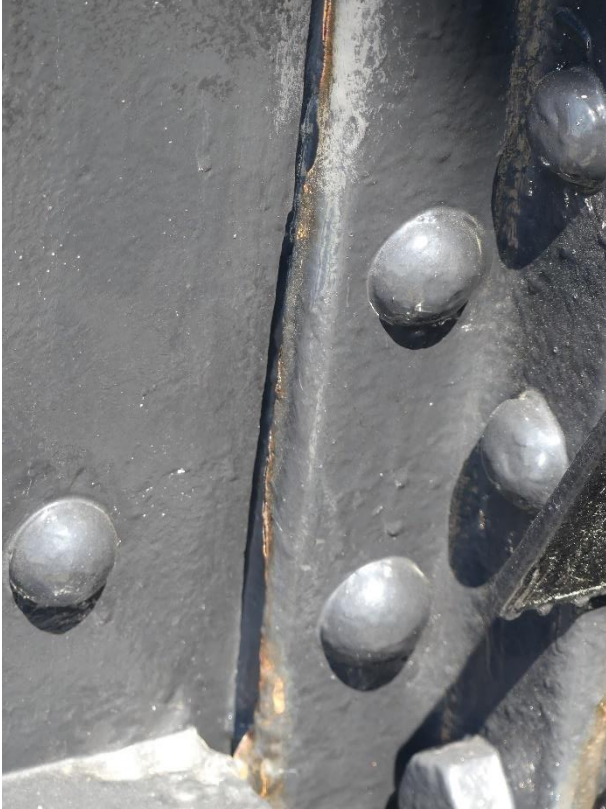
Photo 61 Corrosion entre les éléments / Pylône rive droite aval face intérieure travée 6
