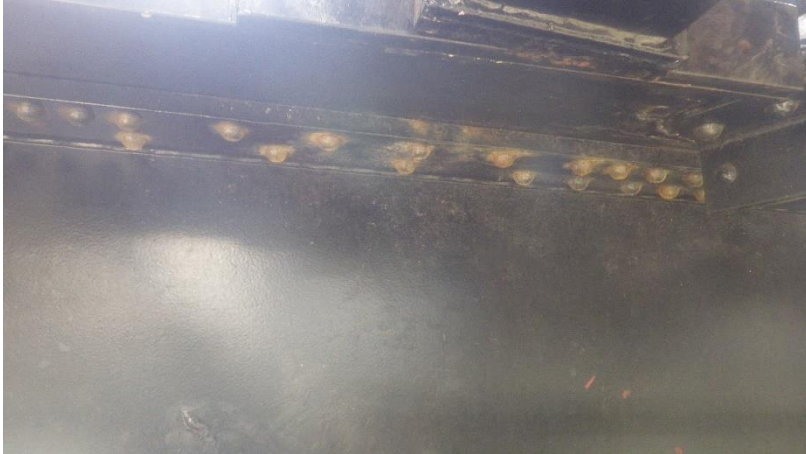
Photo 85 Corrosion des têtes de rivets / Intrados tablier
