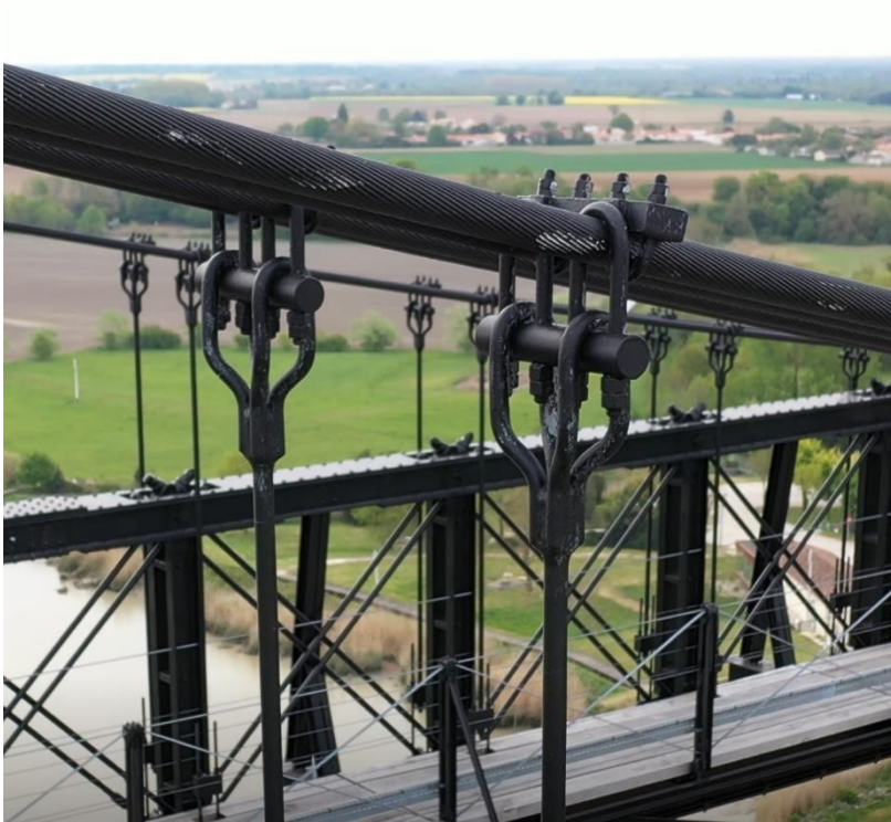
Photo 123 Frottement et manque de revêtement / Câble porteur
