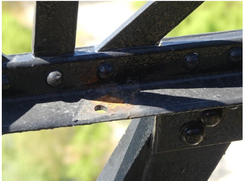
Photo 59 Trou non revêtu et corrodé / Pylône rive droite aval face extérieure travée 5
