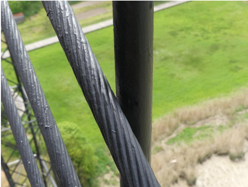
Photo 132 Frottement entre hauban et suspente / Tablier poutre de rive
