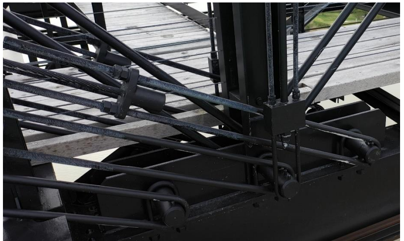
Photo 133 Manque de revêtement anti-corrosion / Haubans
