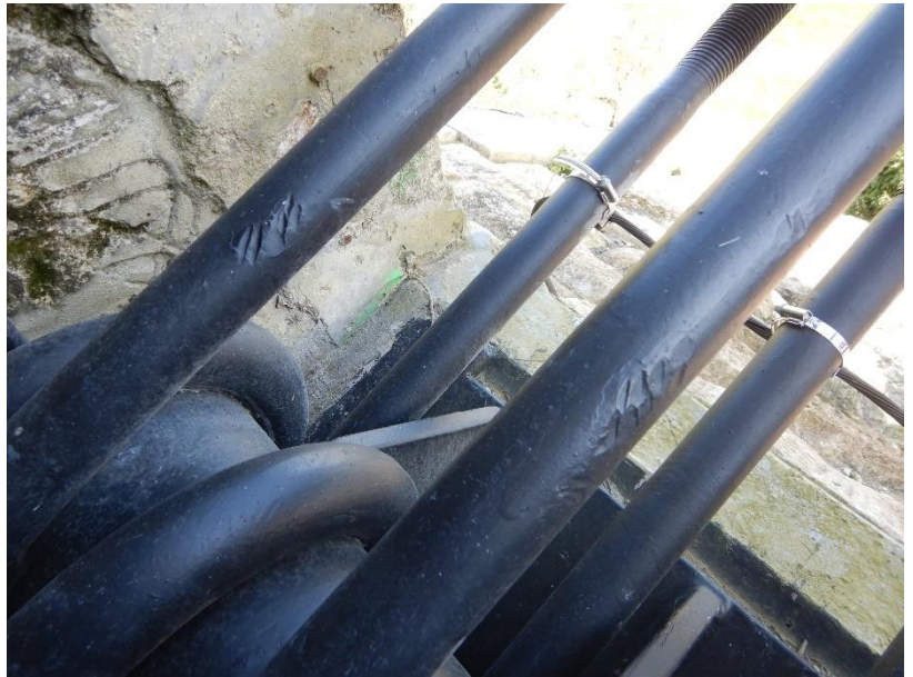
Photo 45 Accros sur les étriers 6 et 7 / ancrage rive gauche aval
