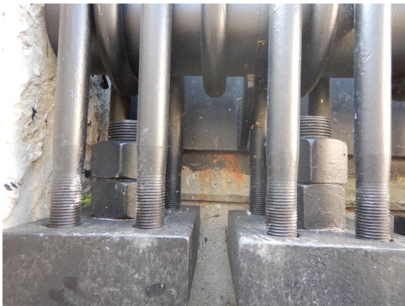
Photo 26 Coulures de rouille sous la selle d'appui / an câbles rive droite aval
