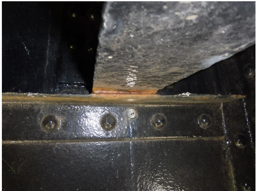
Photo 136 Corrosion des profilés / Selles de déviation
