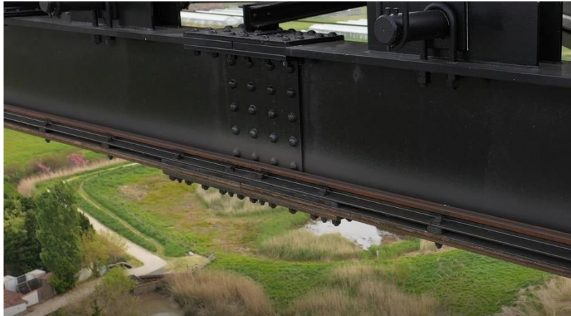
Photo 97 Frottement du profilé par passage du chariot / Tablier poutre de rive
