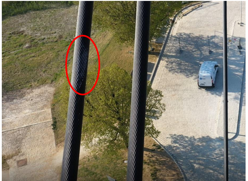
Photo 121 Manque de revêtement anti-corrosion / Câble porteur
