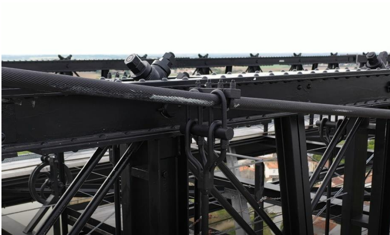
Photo 122 Frottement du revêtement anti-corrosion du câble porteur extérieur aval au niveau de la suspente SE13 / Câbles porteur
