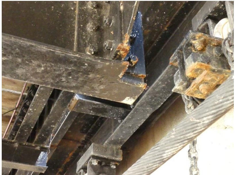
Photo 114 Découpe et corrosion du profilé / Nacelle intrados
