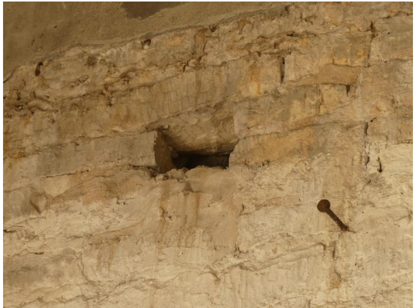
Photo 34 Lacune face Ouest / massif d'ancrage rive droite intérieur
