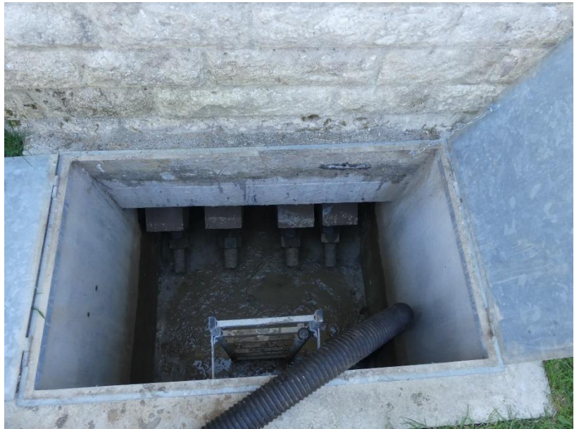
Photo 28 Présence d'eau importante avant pompage / chambre de visite rive droite aval
